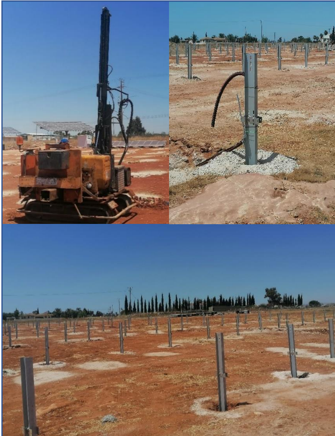
Φωτογραφίες 3: Εργασίες πασσαλόμπηξης.
