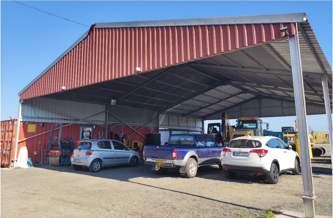
Φωτογραφία 6.1: Μεταλλικό σκέπαστρο που εντοπίζεται εντός του υπό μελέτη τεμαχίου.
