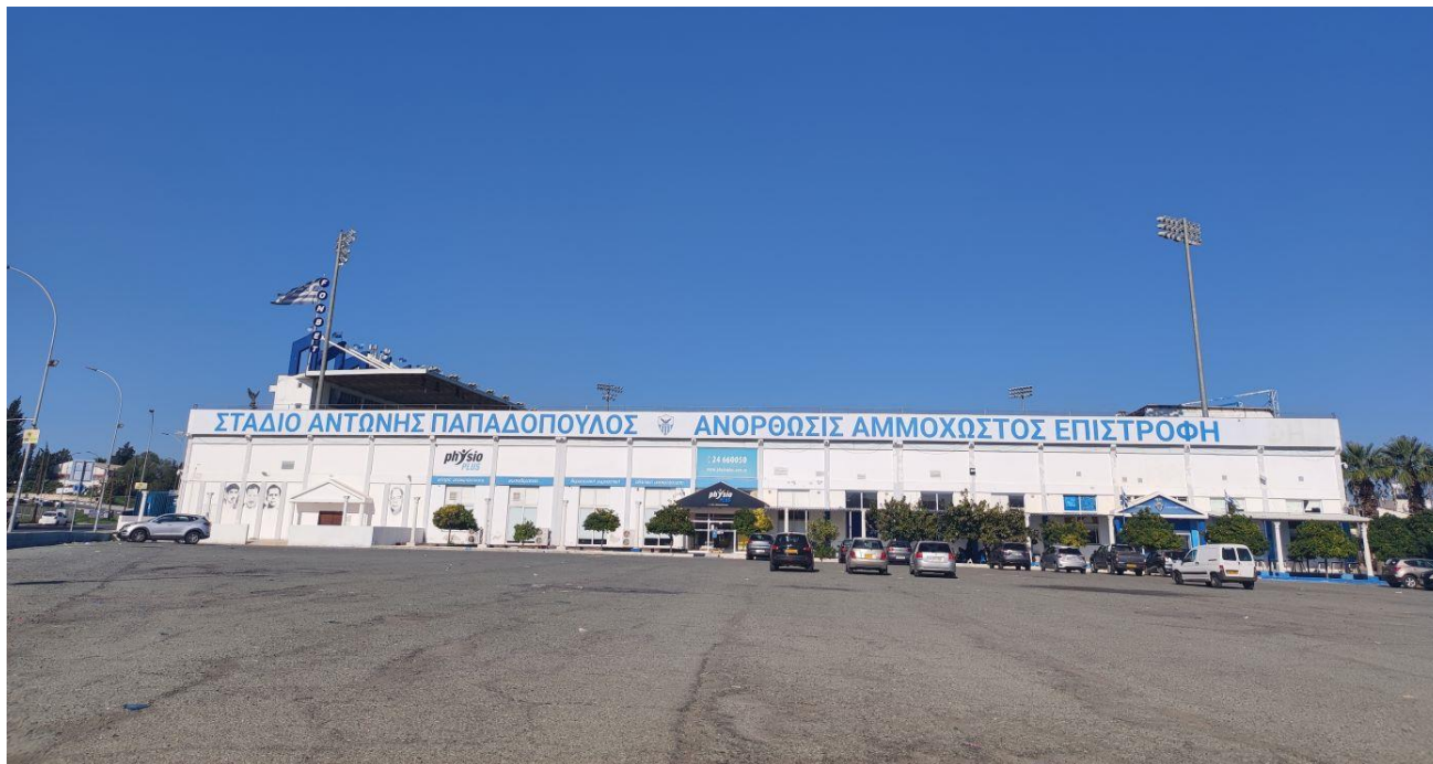
Φωτογραφία 7.17: Γήπεδο Ποδοσφαίρου που εντοπίζεται νότια του υπό μελέτη τεμαχίου.
