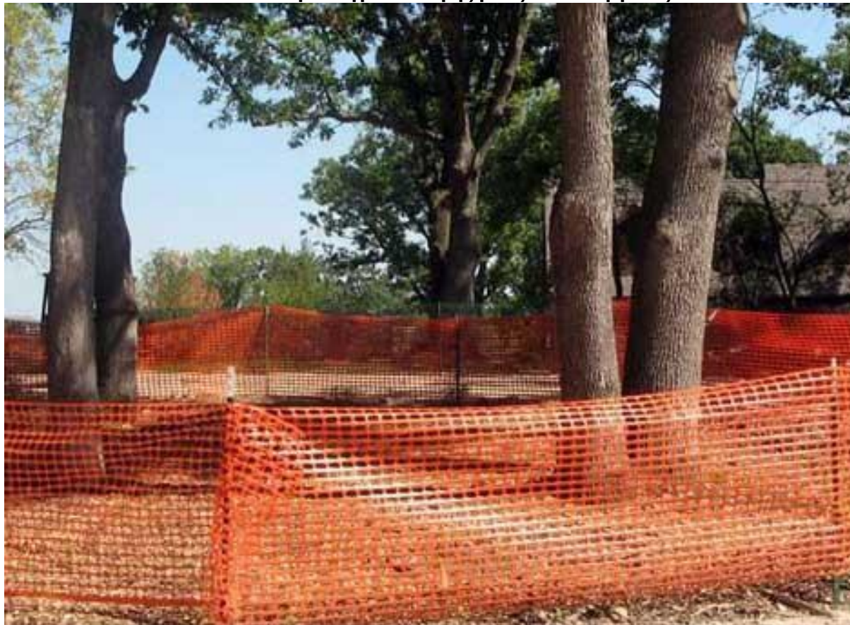
Εικόνα 8-3: Παράδειγμα περίφραξης δέντρων για την προστασία τους
