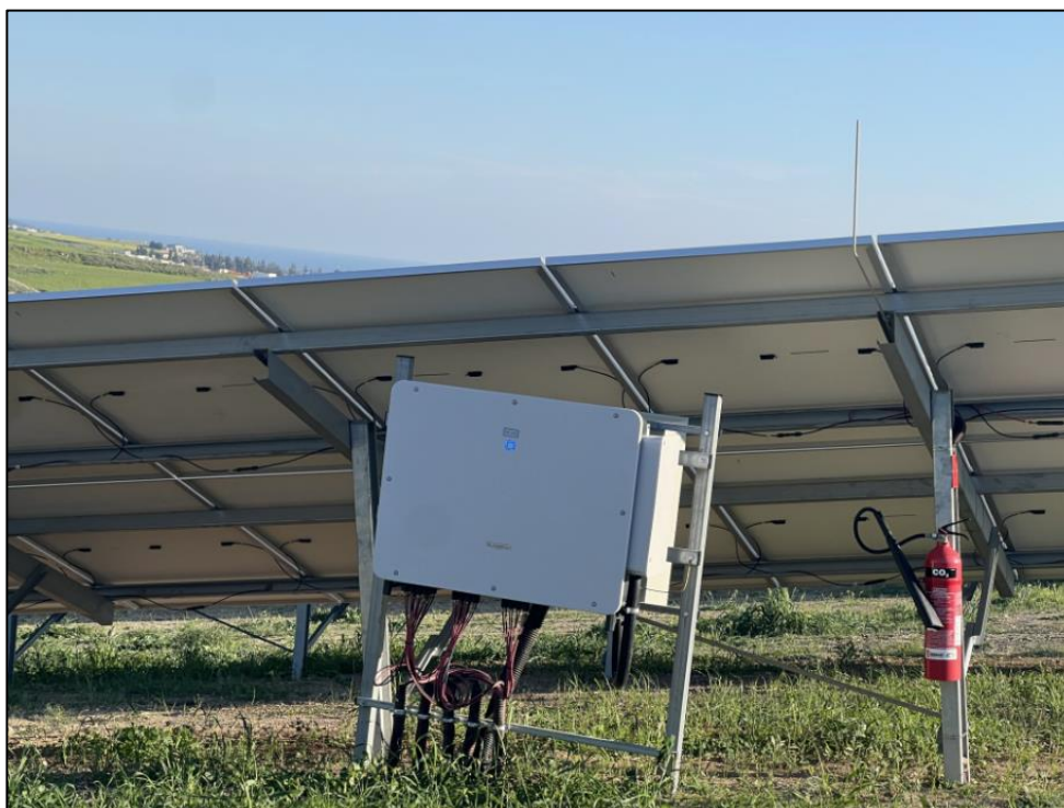
Εικόνα 4-6: Παράδειγμα μετατροπέα δικτύου
