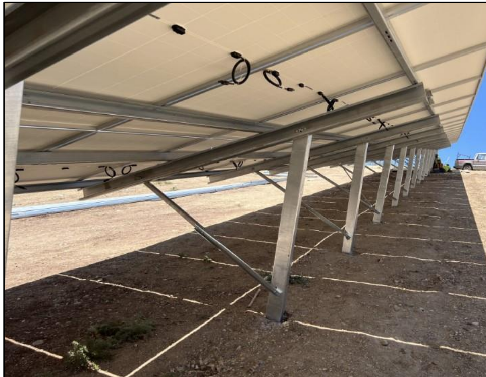
Εικόνα 4-7: Παράδειγμα βάσεων στήριξης φ/β πλαισίων
