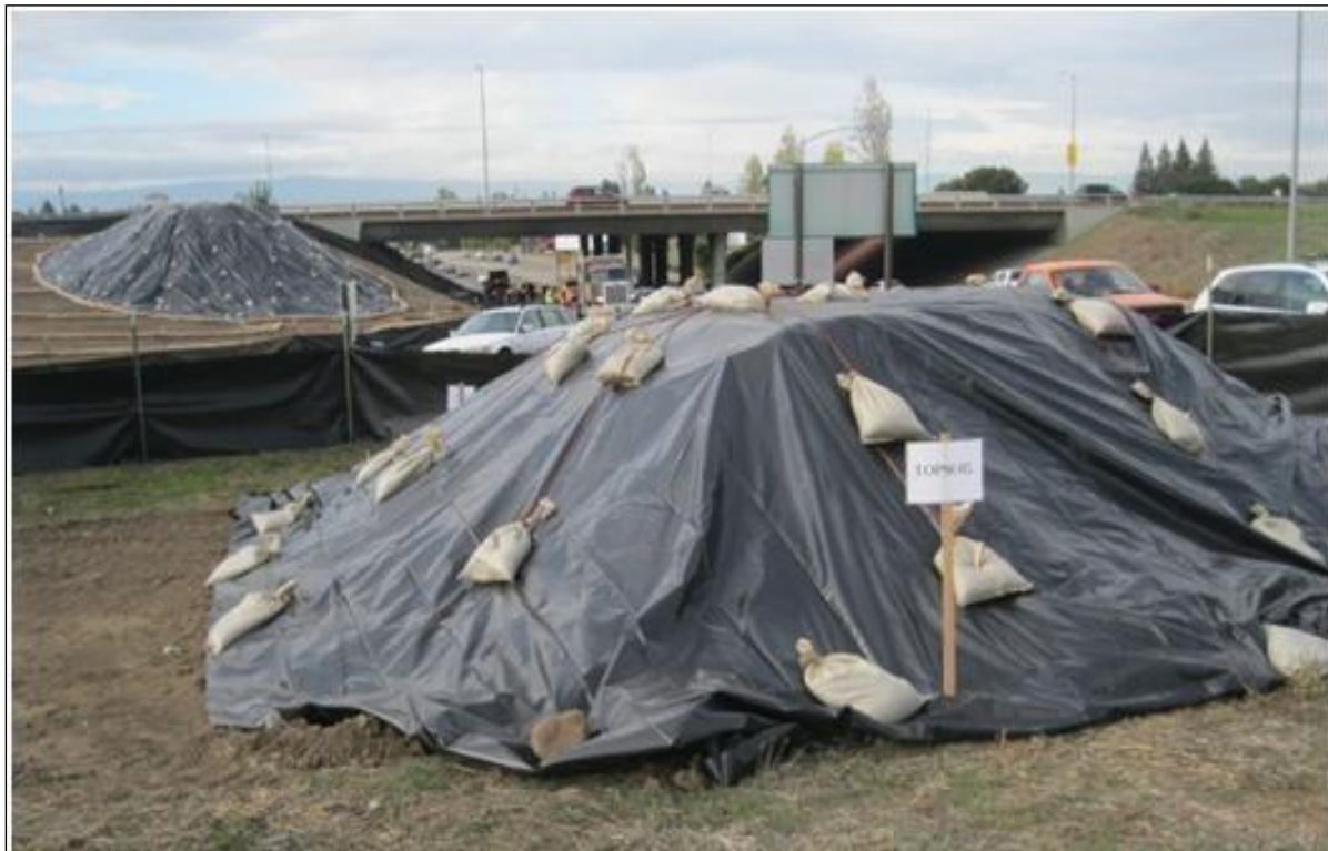
Εικόνα 8-2: Παράδειγμα κάλυψης μπαζών στο εργοτάξιο
