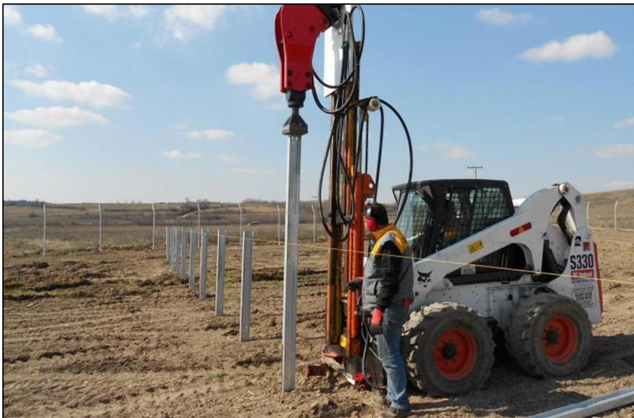
Εικόνα 4-9: Αυτοκινούμενο μηχάνημα τοποθέτησης πασσάλων Φ/Β Πλαισίων [Πηγή: www.edrasol.gr ]
