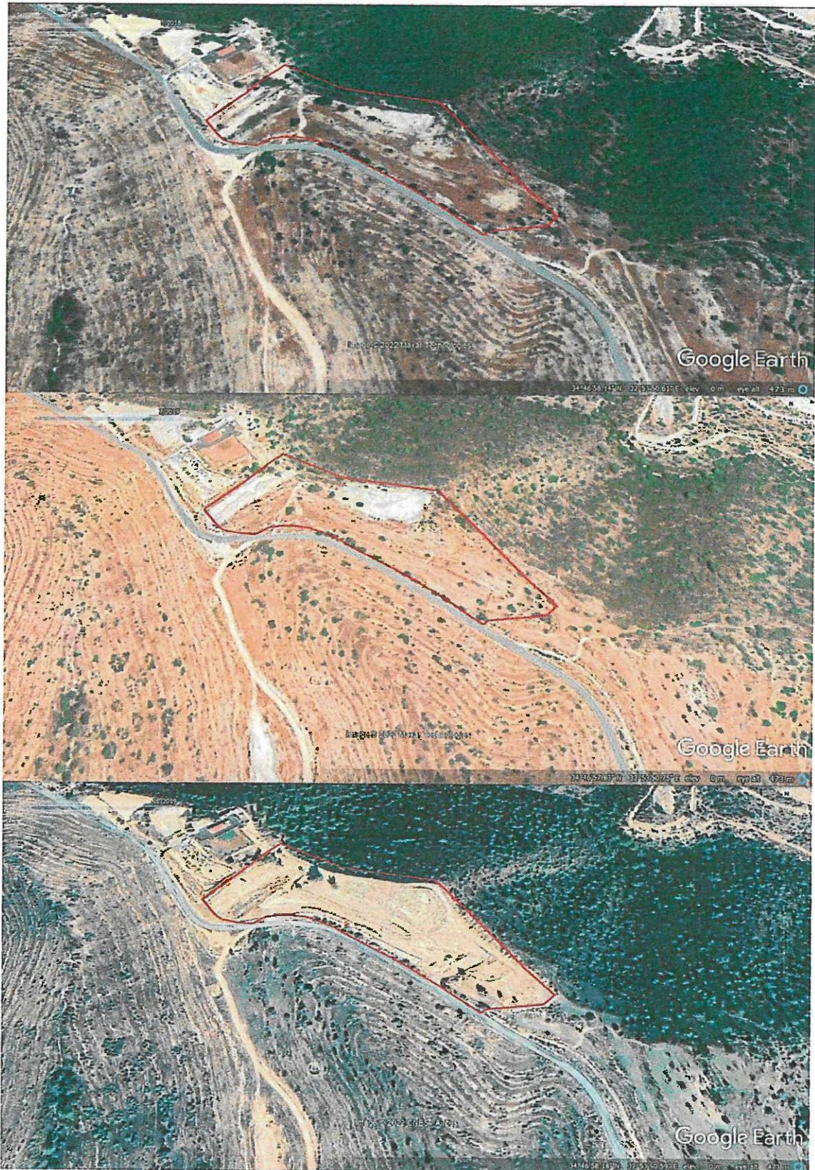
Εικόνα 1: Δορυφορικές λήψεις του τεμαχίου χωροθέτησης του προτεινόμενου έργου (οριοθέτηση με κόκκινο χρώμα), οι οποίες απεικονίζουν την εξέλιξη των προπαρασκευαστικών / χωματουργικών εργασιών (εκχέρσωση, ισοπέδωση, εκσκαφές και επιχωματώσεις). Περίοδος λήψης (από τα πάνω προς τα κάτω): Μάιος 2018, Ιούλιος 2019 και Δεκέμβριος 2019 (Πηγή: Google Earth).
