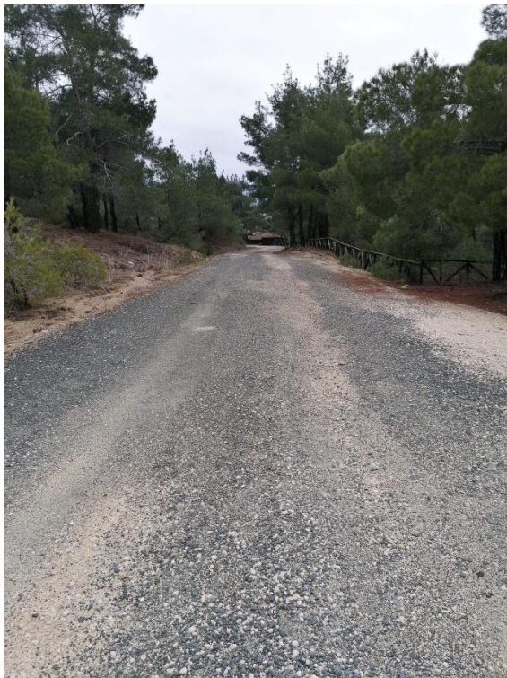
Σχήμα 6. Αδρανές υλικό σταθεροποίησης του οδοστρώματος χωματόδρομου στο Εθνικό Πάρκο Δάσους Δαδιάς-Λευκίμης-Σουφλίου, σε σχετικά επίπεδο έδαφος αριστερά και επικλινές έδαφος στη δεξιά φωτογραφία (φωτ. Φεβρουάριος 2021).
